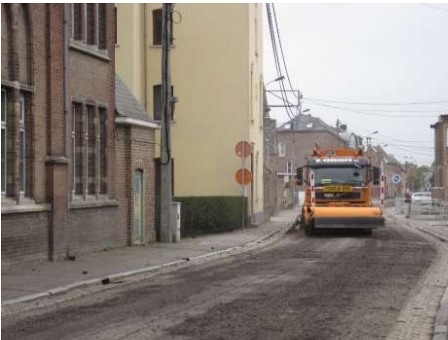
Réfection de la rue du Cimetière FLC
